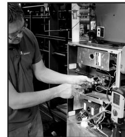
Faire les réglages nécessaires pour une bonne combustion et attendez que l'analyseur affiche les modifications des mesures. (répéter si nécessaire)
